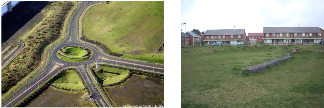
Figura 11: Depósito de detención (Fuente: Universidad de Abertay, Dundee, Escocia)
