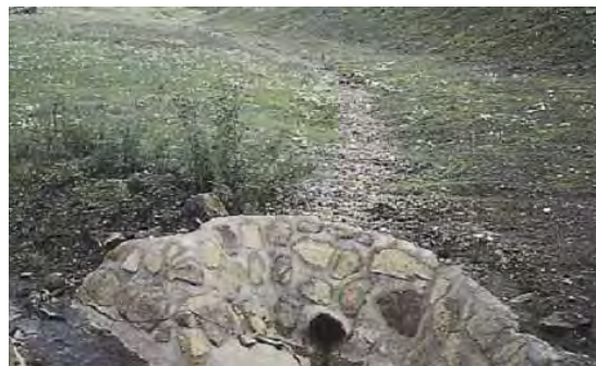
Figura 6: Pozo y zanja de infiltración con superficie de grava (Fuente: CIRIA)
