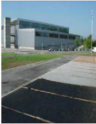
Figura 5: Firme filtrante con distintos tipos de pavimento (Parque de la Guía en Gijón, Asturias 2005)
