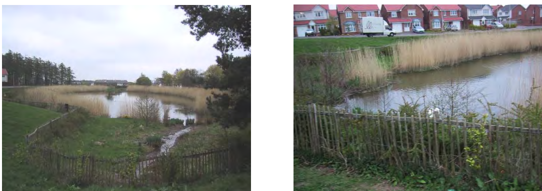
Figura 12: Estanque de retención (Dundee, Escocia 2007)
