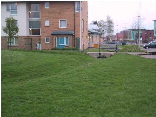
Figura 10: Franja filtrante conectando con cuneta verde (Dundee, Escocia 2007)
