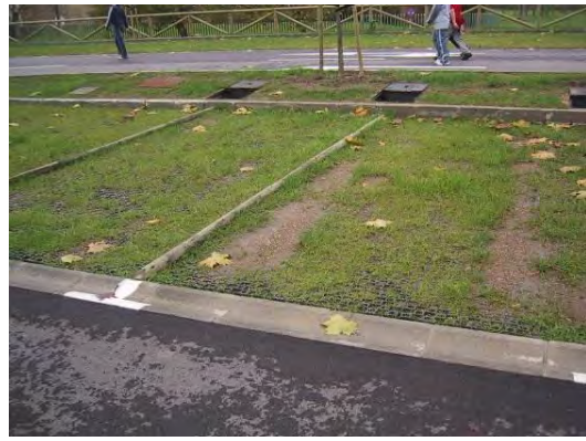
Figura 5: Firme filtrante con distintos tipos de pavimento (Parque de la Guía en Gijón, Asturias 2005)
