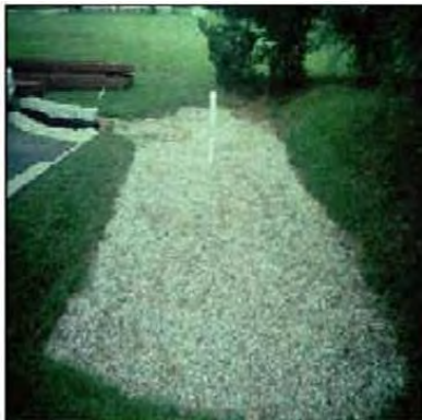
Figura 6: Pozo y zanja de infiltración con superficie de grava (Fuente: CIRIA)
